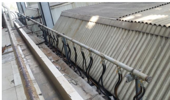
活性炭喷射管组整体安装
