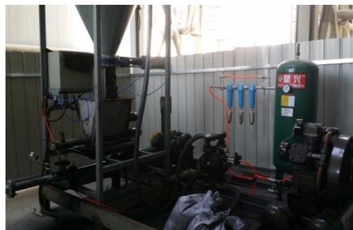
活性炭喷射装置整体连接
